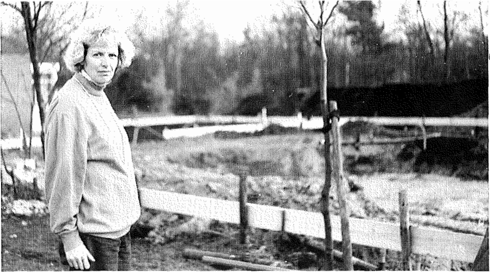
Mevrouw Bruinewoud voor de fundamenteën van het nieuw aan te leggen zwembad bij de camping „Strandheem”.
